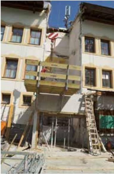
Derzeit sind die Arbeiten für die Herstellung der Barrierefreiheit beim Gemeindehaus voll im Gange. Teile der ersten Stiegen wurden bereits montiert. Mit Ende September konnten die Baumeisterarbeiten größtenteils abgeschlossen werden. Mit der Gesamtfertigstellung kann bis Ende Oktober/Anfang November gerechnet werden.
